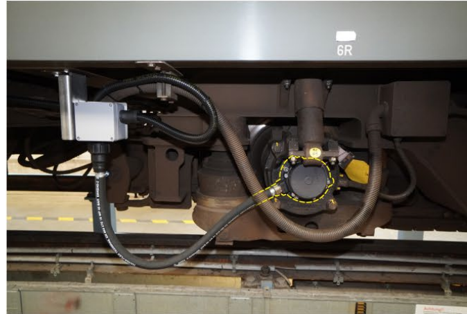
Wegimpulsgeber unter einer S-Bahn der Baureihe 430
