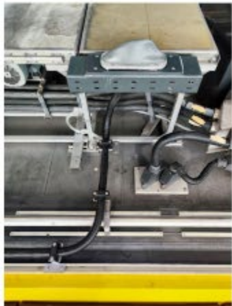
Antenne für 4G/5G auf dem Dach eines FLIRT 3
