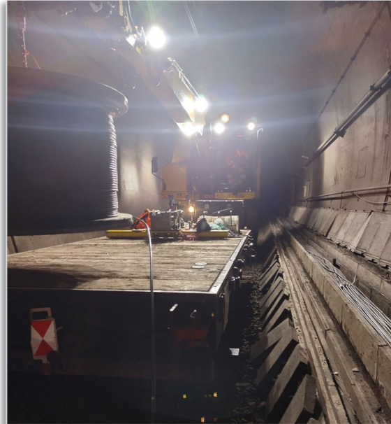
Kabelzug in eingleisigem S-Bahn-Bestandstunnel (August 2023)
