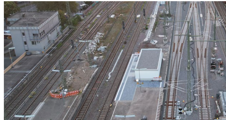
Bestandsstellwerk (links) und einer der beiden neuen Gleisfeldkonzentratoren (rechts) in Bad Cannstatt (im September 2023)
