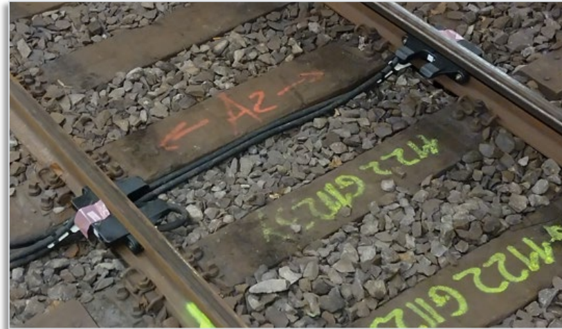
Gedoppelte Achszählpunkte auf der Stammstrecke (September 2023)
