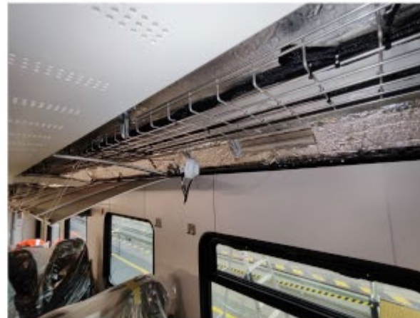
Verkabelungsarbeiten im FLIRT 3
